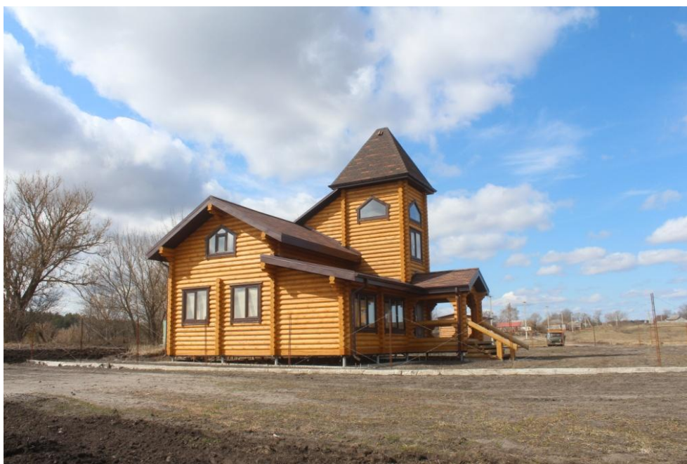
Рис. Строящийся Информационный эколого-просветительский центр «Стенки-Изгорья» заповедника «Белогорье» в с. Таволжанка
